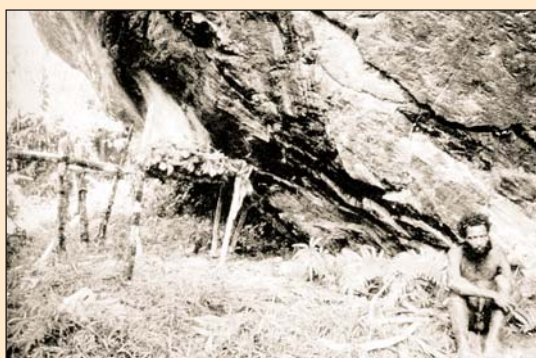
■ Obr. 7. Těžba kamenné suroviny se na Vysočině Nové Guineje odehrává buď u velkých bloků skal anebo v říčních korytech. V obou případech je základním krokem vystavení kamene vysoké teplotě prostřednictvím ohně, které je následováno vylamováním bloků pomocí dřevěných sochorů. Obrázek zobrazuje právě tuto první fázi, při které oheň na dřevěné plošině rozpáluje skálu (převzato z Hampton 1999, 233).
